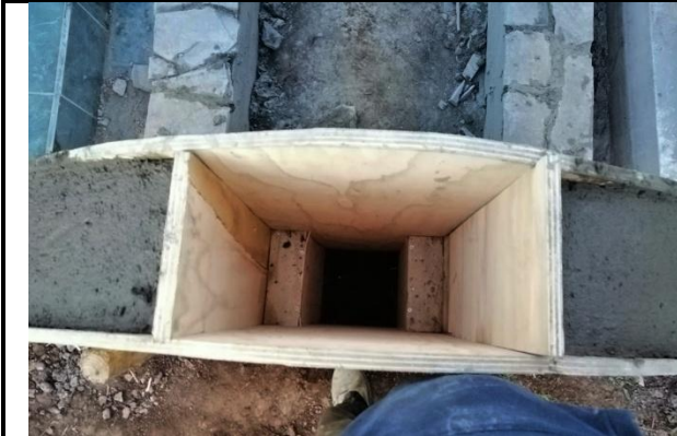
Moldaje para el sostén de Chemamüll
