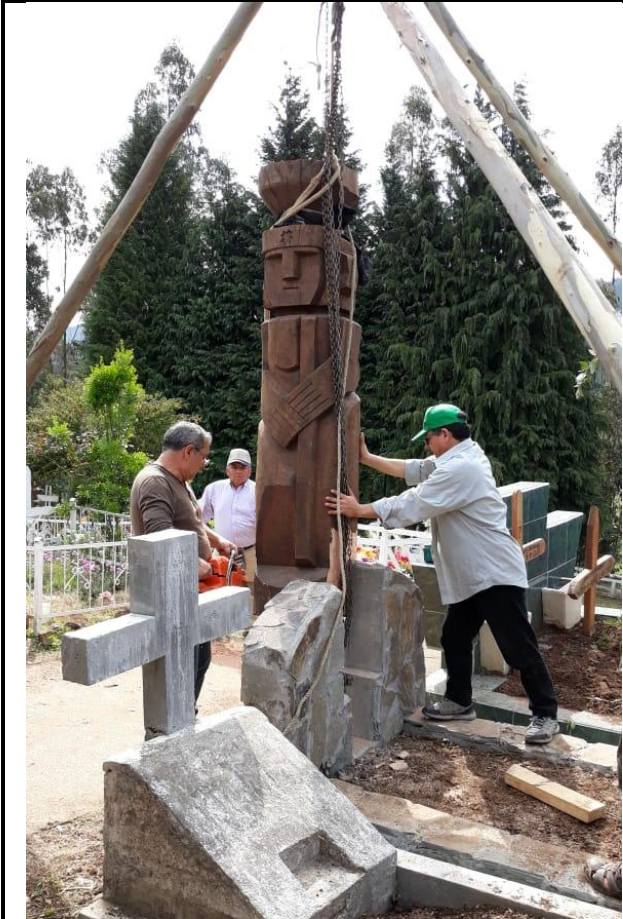
Instalación del Chemamüll
