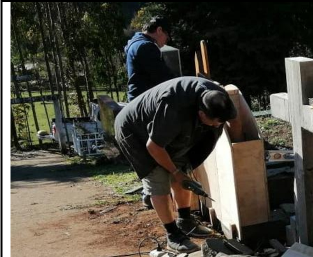
Preparando el Moldaje para el sostén de Chemamüll
