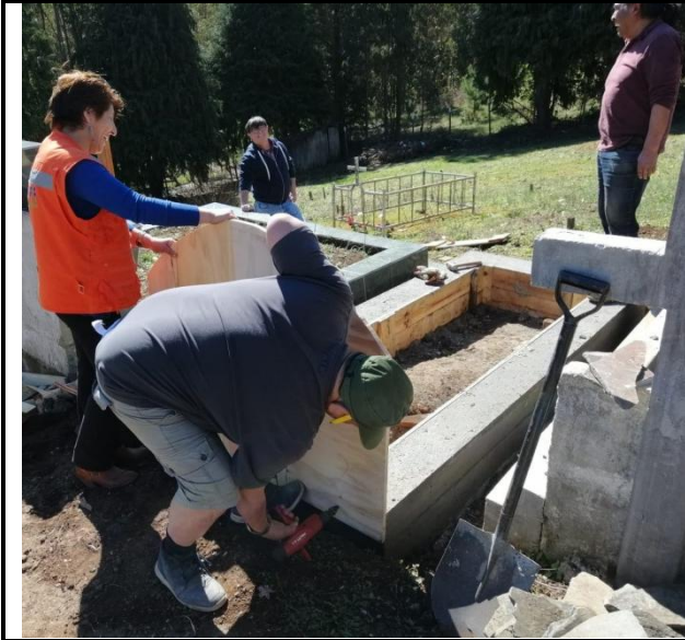
Preparando el Moldaje para el sostén de Chemamüll
