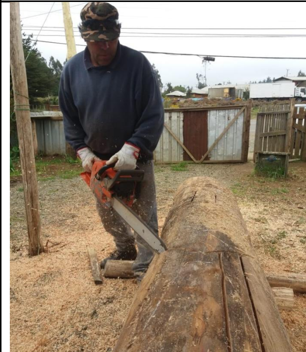
Construcción del Chemamüll
